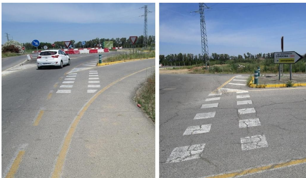
Imagen 4: Continuidad del arcén-bici en antigua rotonda.
