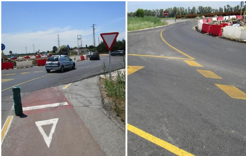
Imagen 3: Discontinuidad del arcén-bici en nueva rotonda.
